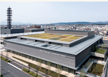
奈良県コンベンションセンター
