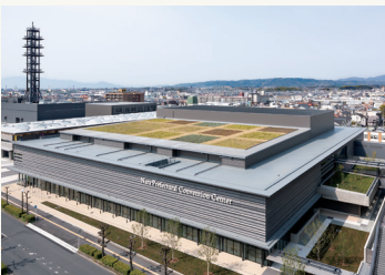
奈良県コンベンションセンター
